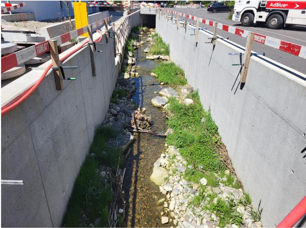
**Abbildung 22: Beispiel eines strukturierten und vielfältigen Gerinnes (Schäflibach Urdorf) mit durchgängigen Querriegeln, eingebunden mit beidseitigen Stützmauern im Siedlungsgebiet (realisiertes Hochwasserschutzprojekt HOLINGER AG, 2023)**
