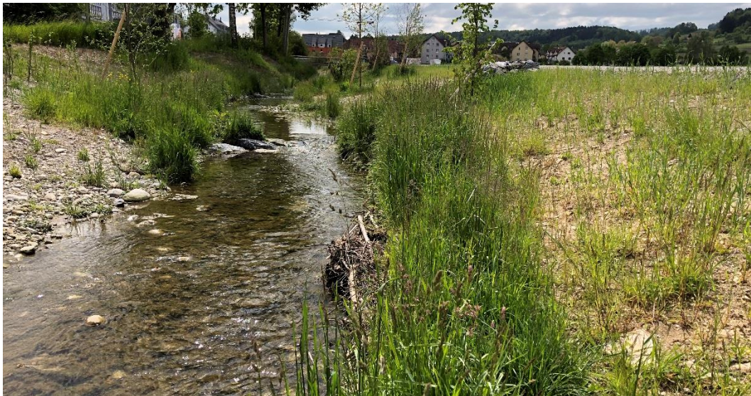
Abbildung 23: Beispiel eines strukturierten und vielfältigen Gerinnes (Schäflibach Urdorf) mit durchgängigen Querriegeln im Siedlungsgebiet (realisiertes Revitalisierungsprojekt HOLINGER AG, 2019)
